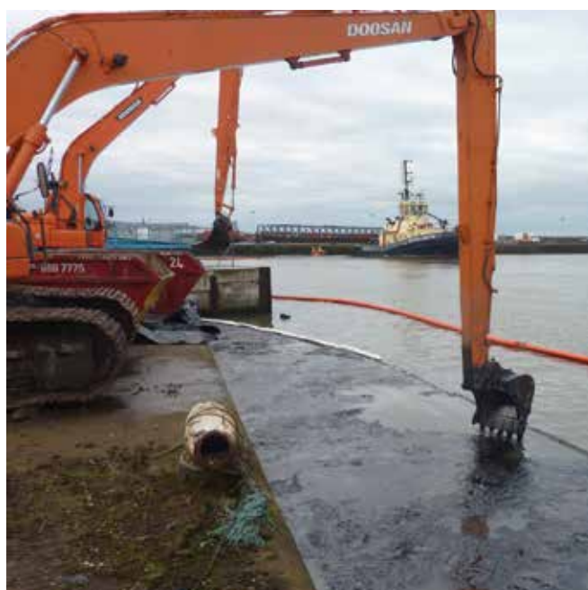
▲ Figure 5 : Engins de terrassement employés pour récupérer des hydrocarbures dans une zone portuaire. Dans cette situation, la température de l'eau étant inférieure au point d'écoulement de l'hydrocarbure, celui-ci est devenu semi-solide et exclut l'emploi de récupérateurs.
