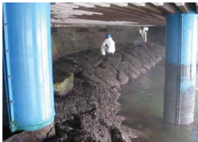
▲ Figure 31 : L'accès sous des quais peut être difficile et dangereux pour les équipes de nettoyage en raison du manque d'espace de manœuvre et de ventilation.
