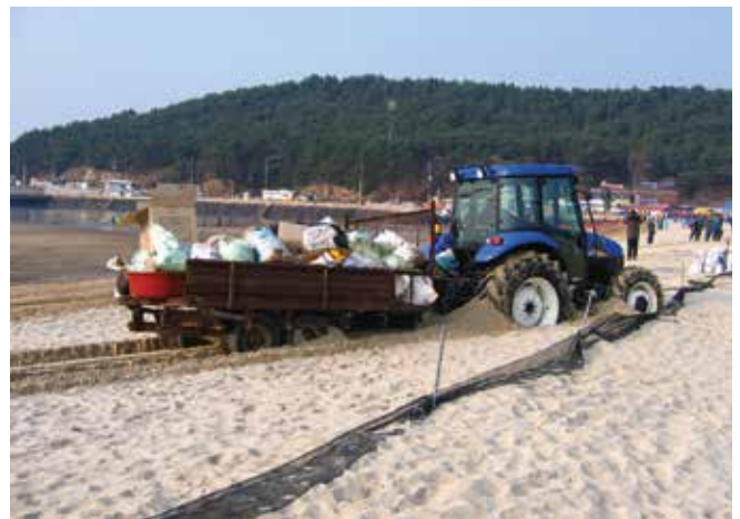
▲ Figure 39 : Les engins chargés peuvent s'enfoncer dans les substrats meubles. Cela peut entraîner des dégâts supplémentaires et l'hydrocarbure peut se trouver mélangé à du sédiment préalablement propre.
