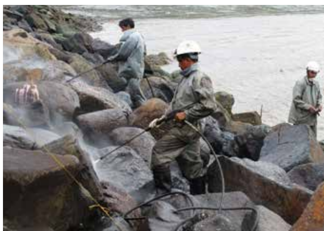
▲ Figure 32 : Nettoyage d'enrochement par jets d'eau haute pression.
