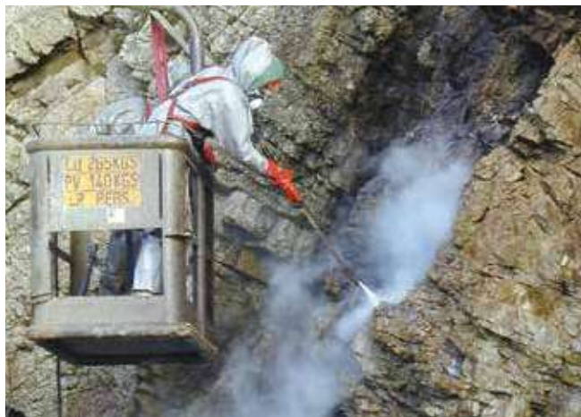
▲ Figure 21 : Lavage haute pression de la face d'une falaise surplombant une plage d'agrément. L'hydrocarbure a été projeté très haut sur la falaise par une tempête et persisterait probablement très longtemps à défaut de nettoyage.
