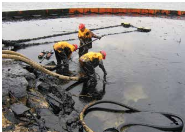
▲ Figure 3 : Récupération d'accumulations d'hydrocarbure liquide du littoral au moyen d'un récupérateur oléophile à cordes et de pompes à vide.
