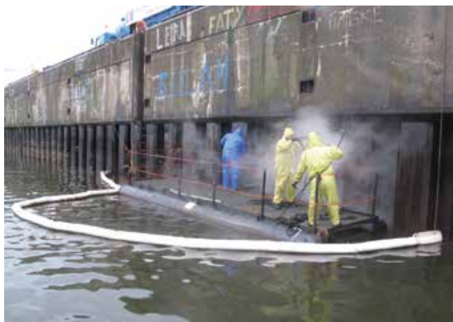
▲ Figure 30 : Pilotis et quai pollués lavés sous pression depuis un ponton. L'hydrocarbure libéré est récupéré par le barrage absorbant.
