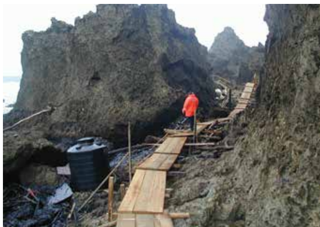
▲ Figure 35 : Pour minimiser les dangers auxquels sont exposés les travailleurs sur les littoraux rocheux, des passerelles temporaires peuvent être construites.
