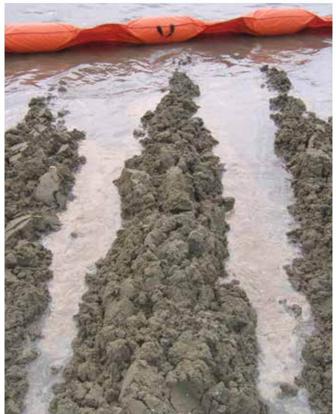
▲ Figure 25 : Substrat de plage contaminé amené à la surface par labourage. L'hydrocarbure est ensuite libéré à la marée montante pour être récupéré au bord de l'eau.
