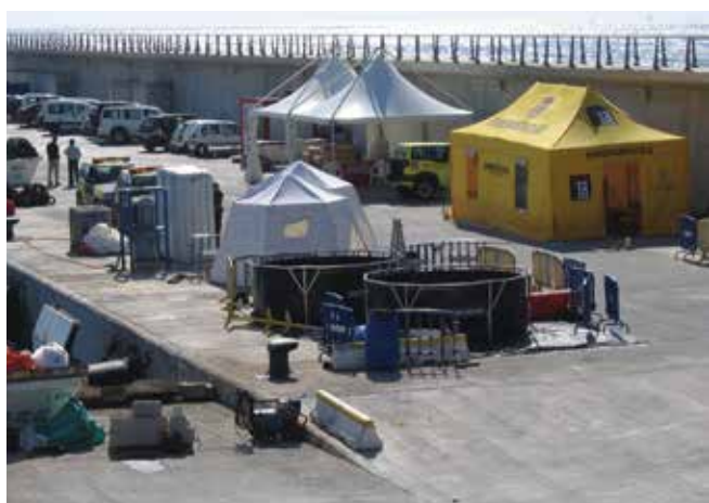
▲ Figure 45 : Des structures temporaires à proximité d'un chantier fournissent des installations de restauration et sanitaires pour les travailleurs.
