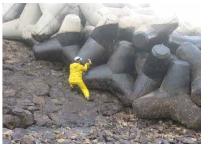
▲ Figure 33 : Le nettoyage de tétrapodes pollués est problématique car les hydrocarbures à l'intérieur de la structure sont difficiles à atteindre.
