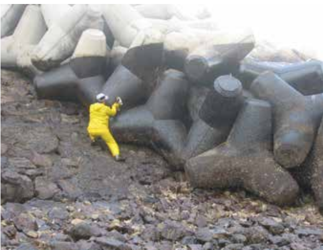
▲ Figure 29 : Les hydrocarbures peuvent être piégés entre les ouvrages de défense, comme ces tétrapodes, masquant la véritable quantité arrivée sur le littoral.
