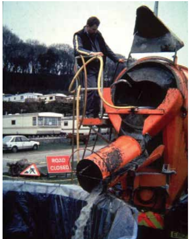
▲ Figure 24 : Effluent déchargé d'un camion toupie malaxeur de béton après le lavage de graviers et de petits galets.
