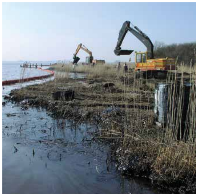
▲ Figure 41 : L'utilisation d'engins lourds sur des zones sensibles du littoral peut causer des dégâts supplémentaires considérables. Dans ce cas, la nécessité de récupérer rapidement les hydrocarbures flottants est une priorité.
