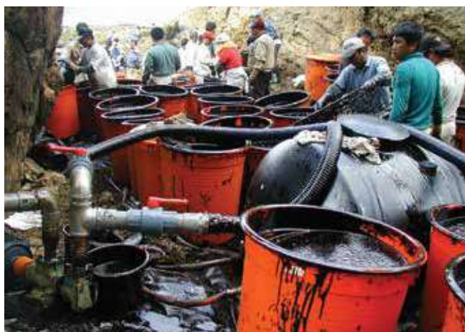
▲ Figure 13 : Hydrocarbures récupérés sur un littoral rocheux temporairement stockés dans de grands réservoirs ouverts. Des pompes sont utilisées pour transférer ce polluant jusqu'au sommet de la falaise puis vers des camions-citernes.
