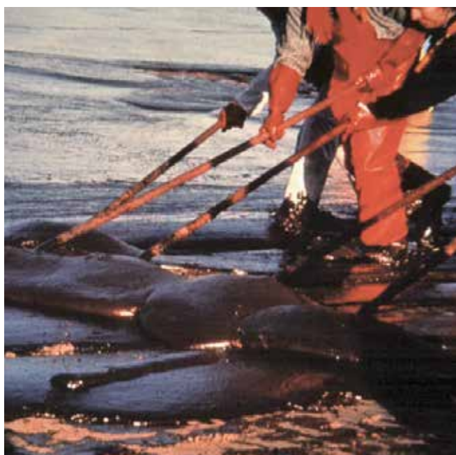
▲ Figure 12 : Pétrole brut raclé le long d'une plage de sable compact pour être récupéré dans des tranchées, puis collecté par des camions hydrocureurs avant d'être transporté jusqu'au site d'élimination.
