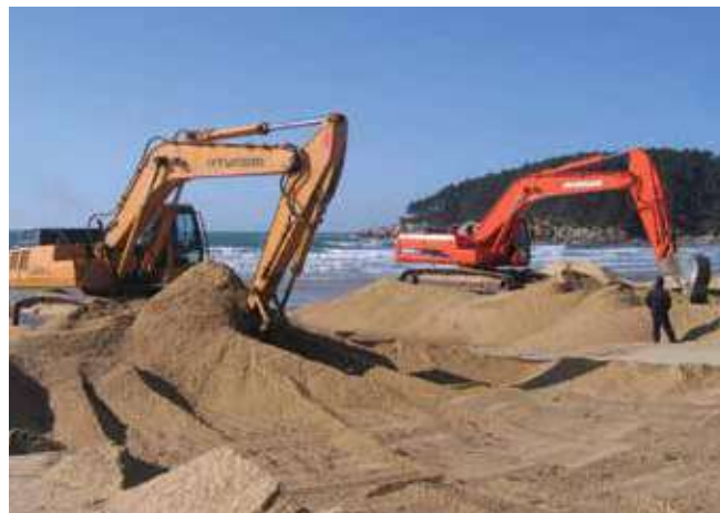
▲ Figure 18 : Sable légèrement contaminé déplacé vers la zone de déferlement pour être lessivé par les marées suivantes.
