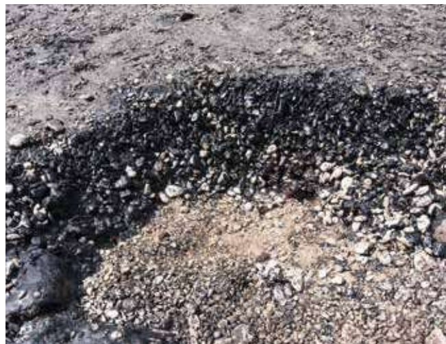
▲ Figure 13 : Forte pollution avec pénétration dans une grève de gravier.
