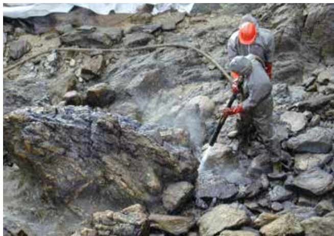
▲ Figure 17 : De l'eau à basse pression est utilisée pour déloger l'hydrocarbure entre les rochers avant de le récupérer au moyen de matériau absorbant en aval du littoral.
