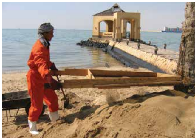
▲ Figure 27 : Tamis improvisé pour récupérer des boulettes d'hydrocarbure.
