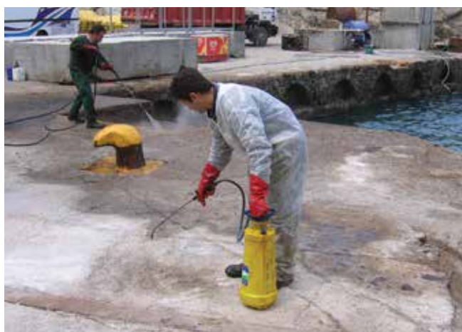
▲ Figure 23 : Un nettoyant chimique est appliqué sur une tache d'hydrocarbure, avant lavage haute pression.
