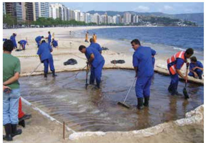
▲ Figure 16 : Hydrocarbure enfoui dans une plage de sable lavé à basse pression au moyen de lances et de tuyaux perforés. Le substrat est également agité manuellement pour favoriser la séparation entre l'hydrocarbure et le sable. L'hydrocarbure est ensuite récupéré par le barrage absorbant qui entoure le chantier.
