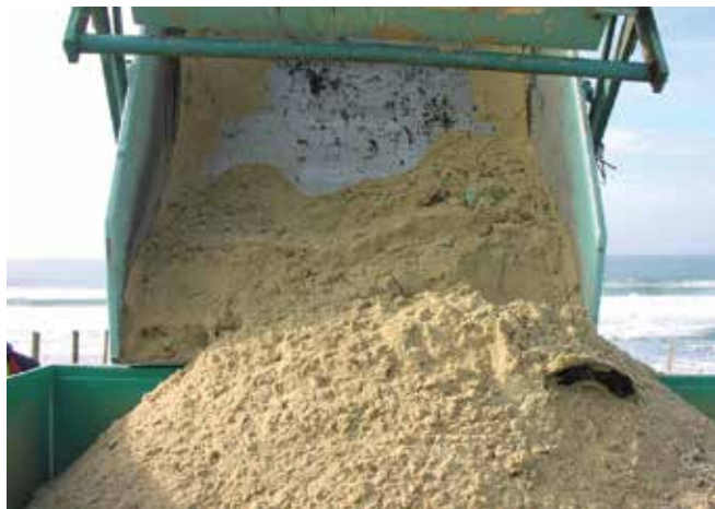
▲ Figure 7 : La collecte directe au moyen d'engins lourds a résulté en une forte proportion de sédiments propres et de très faibles concentrations de polluant dans les déchets.
