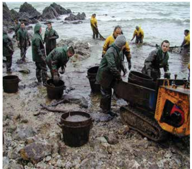
▲ Figure 1 : Collecte manuelle d'accumulations d'hydrocarbures. L'utilisation de main-d'œuvre pour la récupération sélective sur un littoral minimise la quantité de substrat propre collecté.
