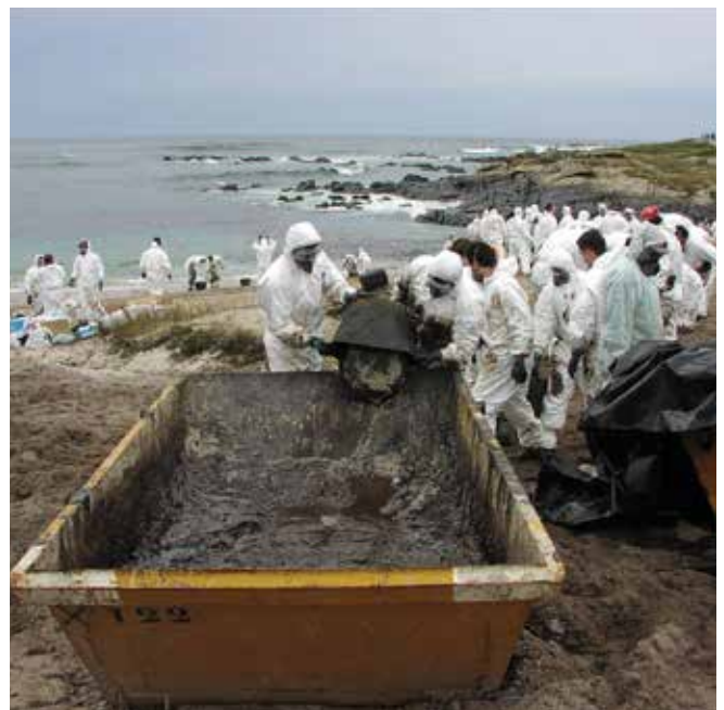
▲ Figure 15 : Chaîne de travailleurs vidant des seaux d'hydrocarbures et de sédiments pollués dans une benne utilisée pour le stockage temporaire.
