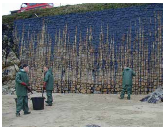
▲ Figure 15 : Pollution massive d'un mur de soutènement à la suite d'une surcôte lors d'une marée de tempête.
