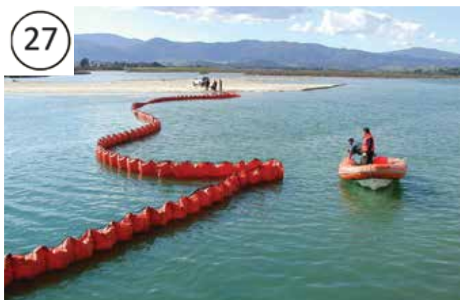
Figure 5 : Site de déploiement de barrage près de l'embouchure du fleuve. Le barrage est posé de manière à dévier l'hydrocarbure vers un point de collecte facilement accessible sur le littoral.
