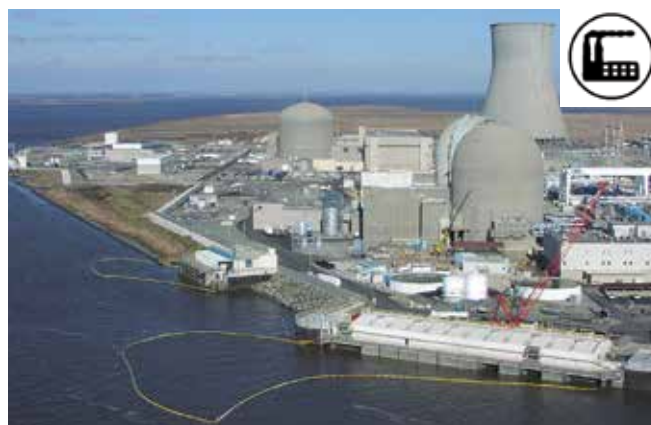
Figure 6 : Centrale électrique avec prise d'eau au premier plan. Plusieurs barrages de déviation sont déployés pour empêcher la pénétration d'hydrocarbure.
