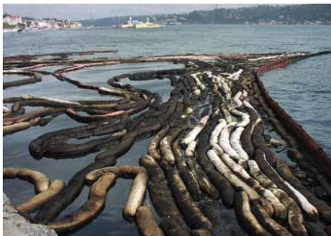
▲ Figure 7 : Barrages absorbants partiellement pollués. L'utilisation massive d'absorbants doit être évitée pour minimiser la production de déchets.
