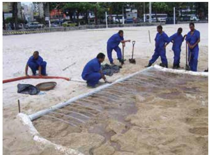
▲ Figure 1 : Nettoyage de sable pollué in situ par lavage basse pression, avec barrage absorbant déployé de manière appropriée pour capturer les hydrocarbures libérés.
