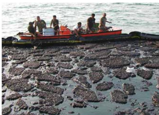
▲ Figure 6 : Hydrocarbure semi-solide confiné dans l'enceinte d'un barrage. Les difficultés de pompage de l'hydrocarbure peuvent limiter les filières d'élimination possibles.
