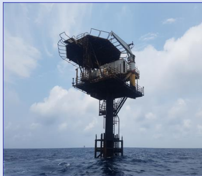
Aperçu de la plateforme pétrolifère abandonnée à Sèmè-Kpodji (Koumba et al, 2019)
