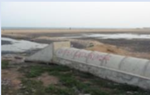
Exutoire des eaux usées sur la plage de Lomé
